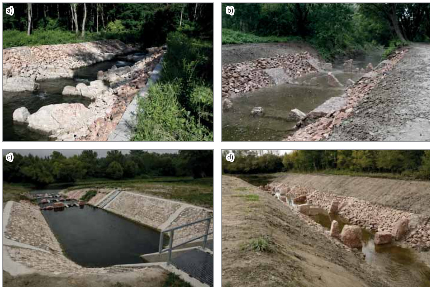
Figure 85: Fish passages in lower Szigetköz; a) Zsejkei, b) Szavai, c) Zámolyi, d) Dunaszegi (Dunai, 2024)
