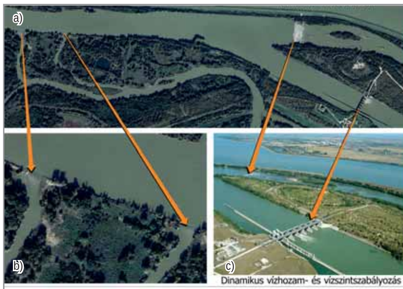
25. ábra – A hullámtér dinamikus szabályozása (a); a hullámtér vízellátását biztosító töltőbukók (b); a fenékküszöb és a dunakiliti duzzasztómű (c)
