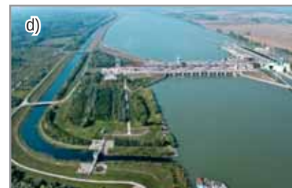
14. ábra – A C-variáns és fő létesítményeinek elrendezése (a). A dunacsúnyi duzzasztómű (b) azért épült, hogy a Dunakiliti duzzasztómű (c) helyett az terelje a vizet az Öreg-Dunából a bósi vízerőmű (d) felé.
