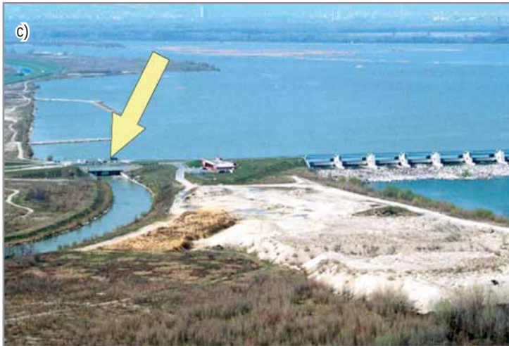
28. ábra – (a) Rajkai-zsilip 1991-ben; (b) Mosonmagyaróvári duzzasztómű 2025-ben; (c) a Mosoni-Duna vízkivételi mű és tápcsatorna a dunacsúnyi tározónál; (d) vízáramlás a tápcsatornában, ahol a Kertész-gát jobbra, a rajkai vízkivételi zsilip felé, majd azon át – az árvízvédelmi töltést keresztezve – a Szivárgó-csatornába juttatja a Mosoni-Duna vizét
